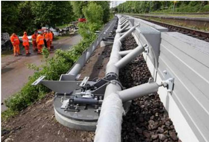
Hydraulisch umklappbare Aluminiumwände
