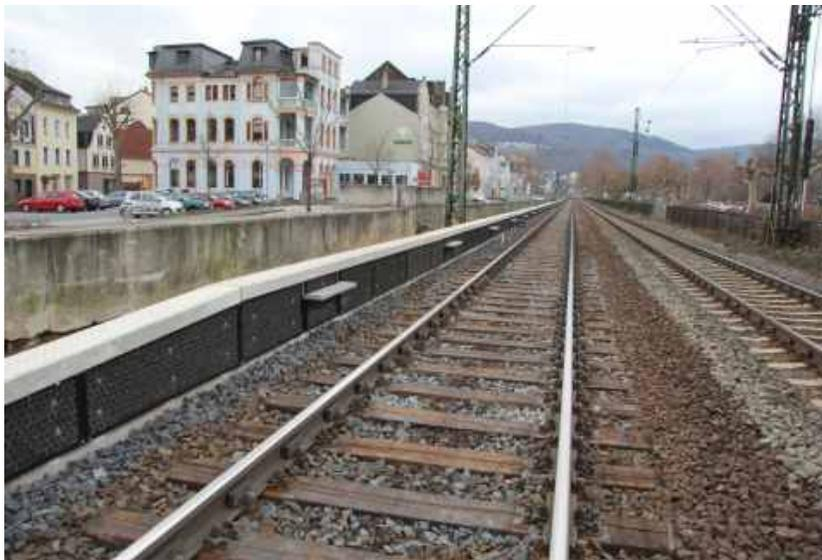
Fertigbetonteile mit Absorber
