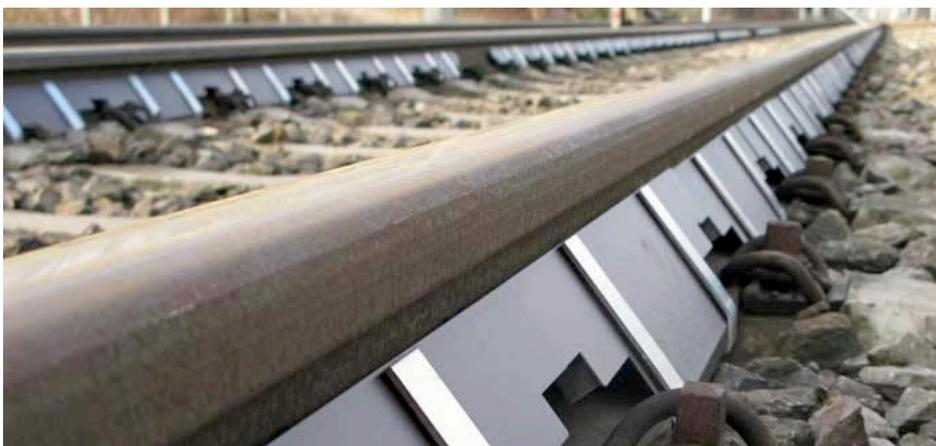
Bild : So sehen sie aus, die Schienenschallabsorber, die momentan an verschiedenen Abschnitten der Rheintalstrecke – vorwiegend in den Nachtstunden – montiert werden, um durch die Bedämpfung der Schienenstege eine Lärmreduzierung zu bewirken. Voll wirksam wird diese aber erst, wenn weitere Maßnahmen wie beispielsweise die Umrüstung der Waggons auf „Flüsterbremsen“ hinzukommen.
